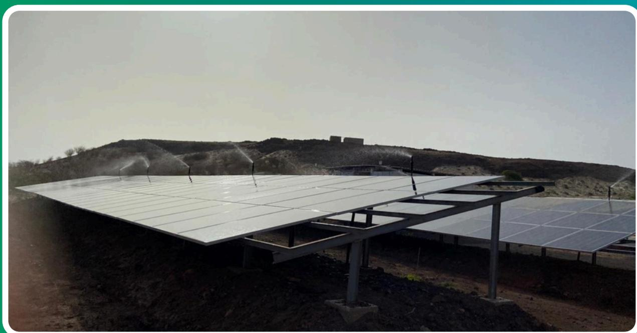
**SISTEMA SOLAR FV INSTALADO NO MOMENTO DE LIMPEZA POR PULVERIZAÇÃO DE ÁGUA**
