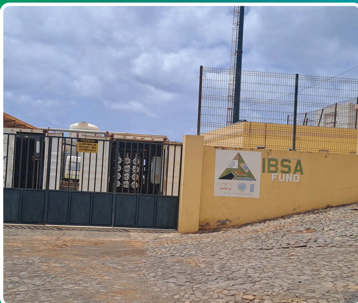
ESTAÇÃO DESSALINIZADORA DE PREGUIÇA PREGUIÇA DESALINATION PLANT
