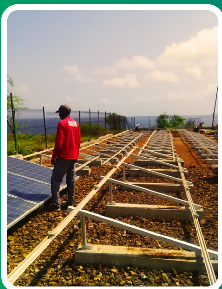
PREPARAÇÃO DO TERRENO E INSTALAÇÃO DO SISTEMA SOLAR FV LAND SITE PREPARATION AND INSTALLATION OF THE SOLAR PV SYSTEM
