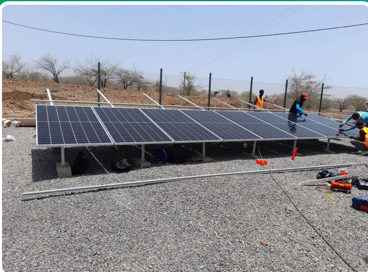
FASE DE CONSTRUÇÃO E INSTALAÇÃO DOS MÓDULOS FV PV MODULE CONSTRUCTION AND INSTALLATION PHASE
