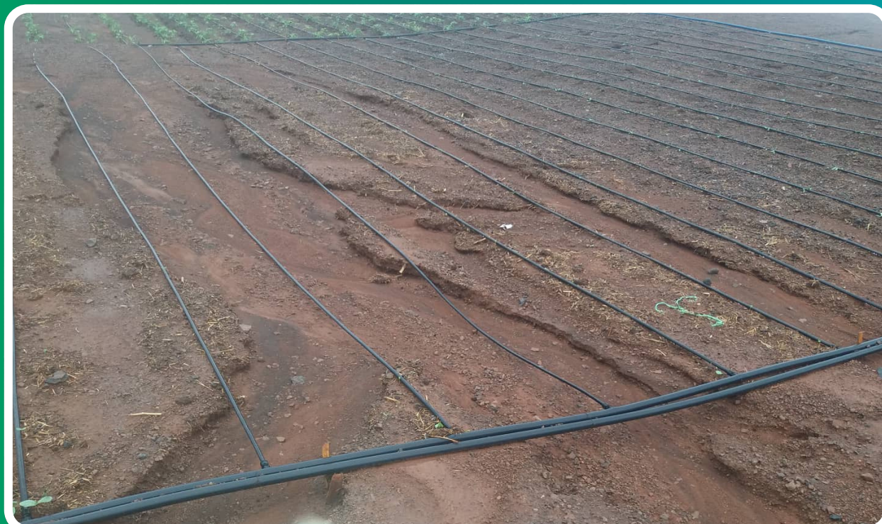
SISTEMA DE IRRIGAÇÃO EM PARCELAS AGRÍCOLAS DO PROJETO IRRIGATION SYSTEM IN THE PROJECT'S AGRICULTURAL PLOTS
