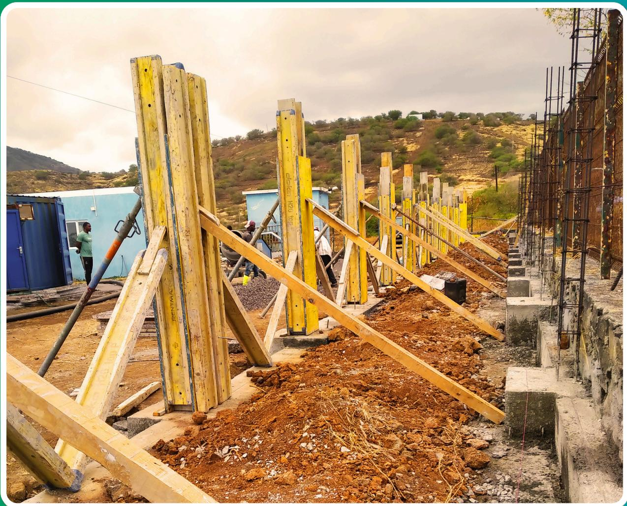
**OBRAS DE CONSTRUÇÃO DA BASE DO SISTEMA FV**
